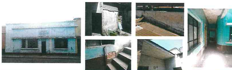
Restauración de casa donada por la SENABED, ubicada en la 10ª. Avenida zona 1
