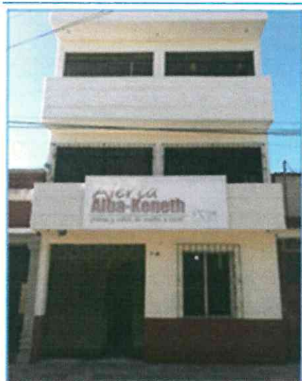
Instalaciones Unidad Alba Keneth
