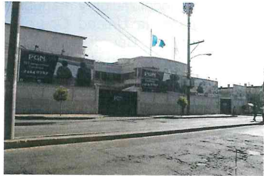
Nueva instalación de Alba Keneth
