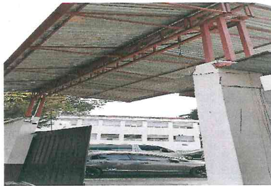
Ingreso al Parqueo A
