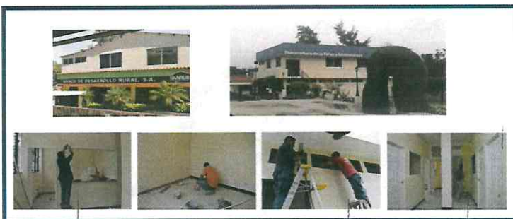
Recuperación y remodelación del inmueble ocupado por Banrural.
