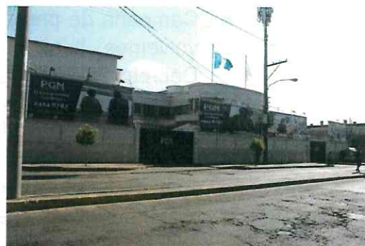
Nueva instalación de Alba Keneth
